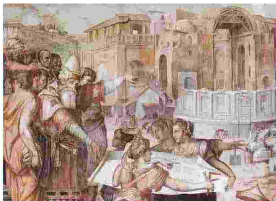
Il cantiere della basilica in un affresco del Vasari
